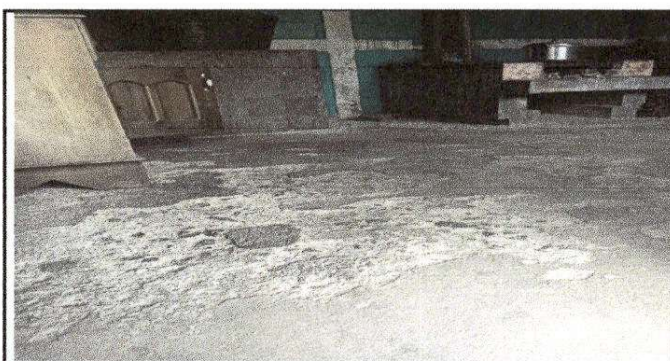
Foto 5: Sustitución piso de torta de concreto por piso de cerámico.
