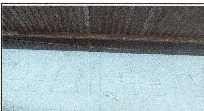
Foto 6: Mantenimiento de estructura de techo.
