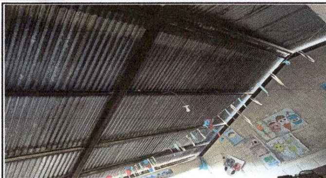
Foto 1: Sustitución de lamina Zinc por lamina troquelada calibre 26.
