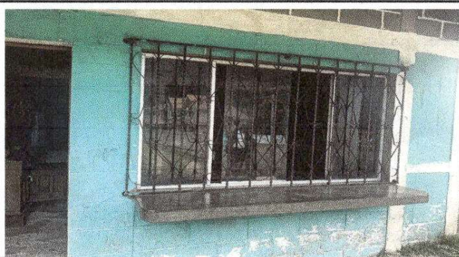
Foto 3: Sustitución de ventana aluminio por ventana a metal más vidrio.
